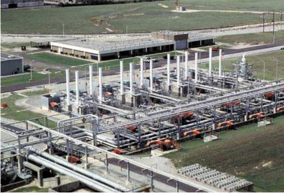
يبين الشكل ٢٦ المبخرات من نوع الاحتراق المغمور التي تستخدم الماء الحار المسخن عن طريق حراق احتراق مغمور لتبخير الغاز المسال في مبادل حراري أنبوبي من الفولاذ هذا النوع من المبخرات له الميزات التالية :
